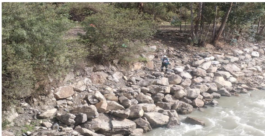
Imagen 02: vista de aguas arriba del puente se observa el enrocado movido por socavamiento de base .
