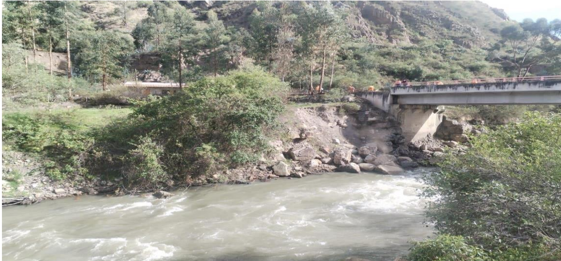
Imagen 1: se observa aguas abajo del puente, erosión lateral en la margen derecha del rio chucpin.
